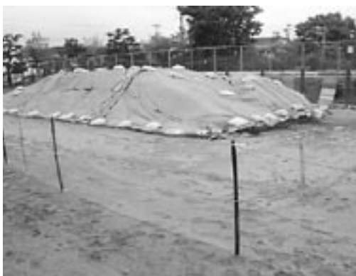
校庭の片隅に仮置きした表土
